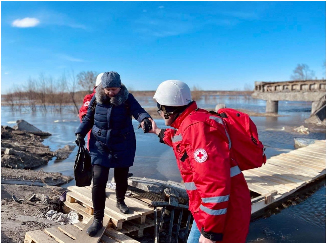
(写真：地元の人と赤十字ボランティアが爆撃によって壊された橋を再建、 赤十字ボランティアが数千人の避難誘導を実施 ©ウクライナ赤十字社)
