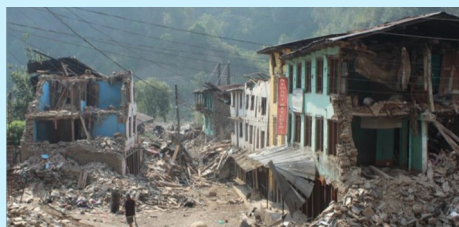
2015年の地震で倒壊した建物
